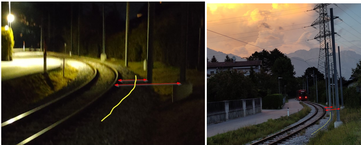
Ca. verdoppelter neuer Mastabstand. Gelb: ca. Verlauf der künftigen Bahnsteigkante (Aufnahmen vom 11.2.2025 und 3.9.2024)
